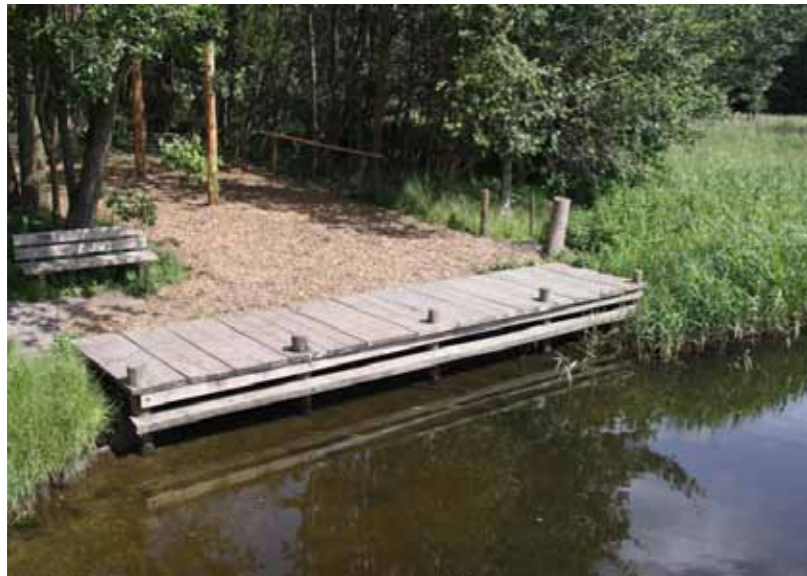
Eksisterende bro ved Solgårdsparken
